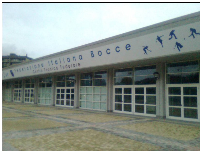
Ingresso Autorità impianto Federbocce (Viale della Grande Muraglia)
